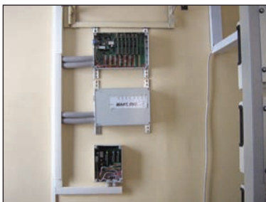
Фото 1. МАКС ЛКС и БИК-Техно, смонтированные на АТС.
