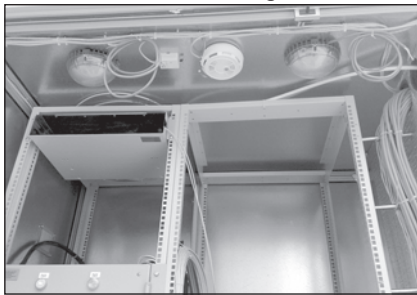
Фото 6. КУБ подключает пожарные датчики как по четырехпроводной, так и по двухпроводной схеме.
