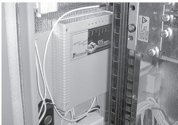
Фото 1. Контроллер КУБ, установленный в телекоммуникационном шкафу.
