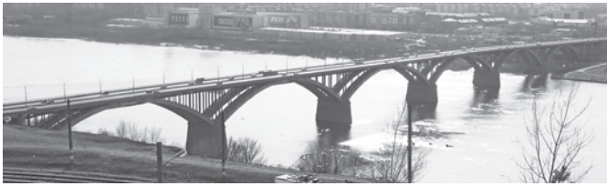
Фото 2. Молитовский мост в Нижнем Новгороде – бывшее место частого хищения кабеля...
