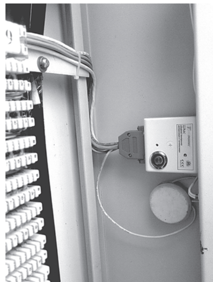
Фото 3. Монтаж ШКАС в РШ
